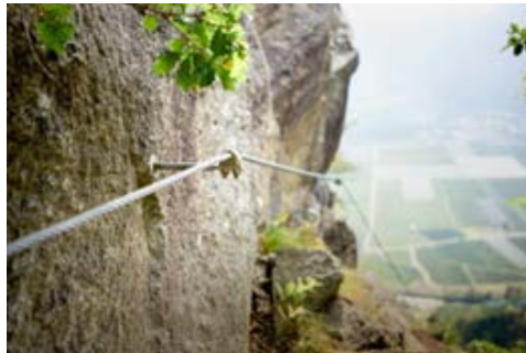
Foto: Andreas Jakwerth Sicherung mittels durchgehenden Stahlseiles
